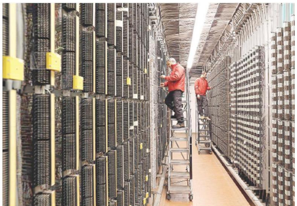
Tecnici di Telecom Italia al lavoro
